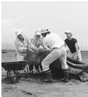
瓦礫の撤去作業の様子
